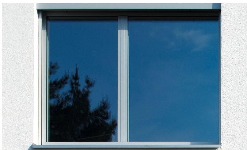
Sanierung mit «Top-Win»-Fenster: minimalster Rahmenanteil, schlanke Mittelpartie.
